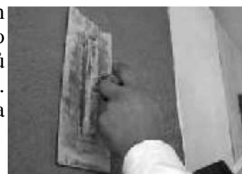
4.15 Vytváření struktury na tenkovrstvé ušlechtilé omítce
