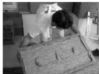
4.4 Nanášení lepící stěrky i izolační desky
