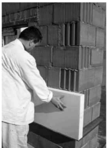
3.5 Založení první řady izolačních desek
