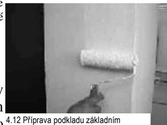
4.12 Příprava podkladu základním nátěrem
