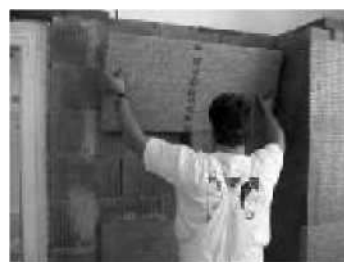
4.5 Kladení izolačních desek
