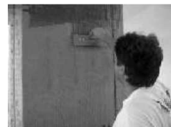
3.16 Vtlačení sklotextilní síťoviny do armovací vrstvy
