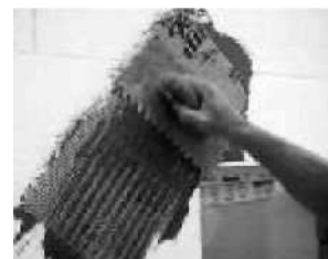
3.19 Detail provedení přidavné výztuže v rozích otvorů
