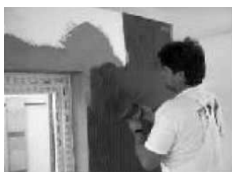
3.14 Nanášení lepicí stěrky na izolační desky
