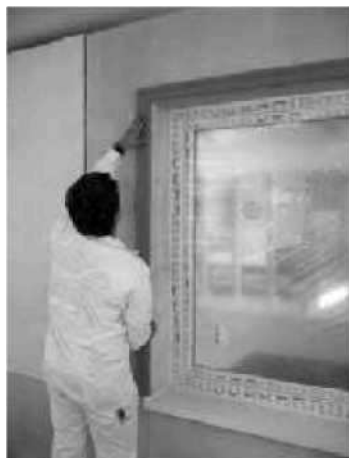
5.4 Aplikace prefabrikovaných fasádních profilů
