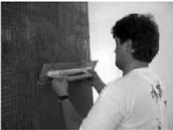
4.9 Nanášení vyrovnávací vrstvy
