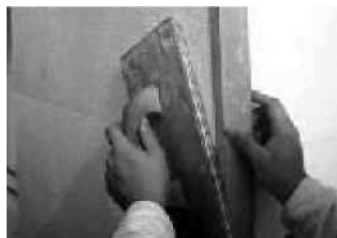
3.13 Broušení izolačních desek
