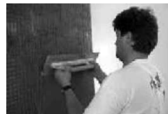
3.17 Zarovnání armovací vrstvy
