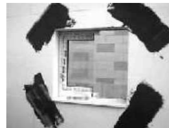
3.20 Přidavná výstuž v rozích otvorů
