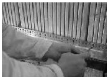
3.3 Montáž soklového profilu - měření rovinnosti
