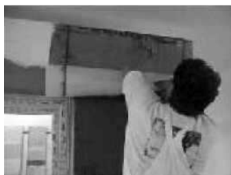
3.15 Aplikace sklotextilní síťoviny do armovací vrstvy
