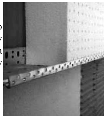
5.1 Detail řešení zateplení v soklové oblasti
