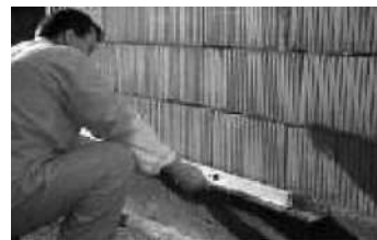
4.2 Montáž soklové ho profilu - měření rovinnost
