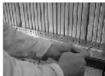
4.3 Kotvení soklové ho profilu k podkladu
