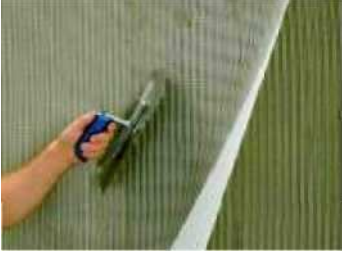
4.7 Vtlačení sklotextilní síťoviny do stěrky.
