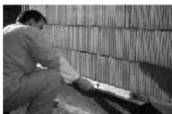
3.4 Kotvení soklového profilu k podkladu
