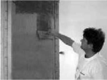
4.8 Nanášení vyrovnávací vrstvy.
