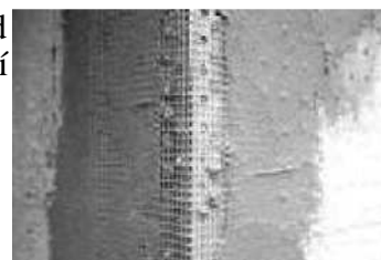
4.11 Použití rohového profilu s integrovanou sklotextilní mřížkou
