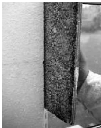
3.12 Broušení izolačních desek
