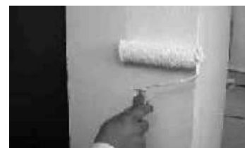
3.21 Příprava podkladu základním nátěrem
