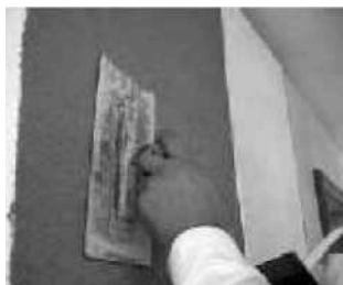
3.24 Vytváření struktury na tenkovrstvé ušlechtilé omítce
